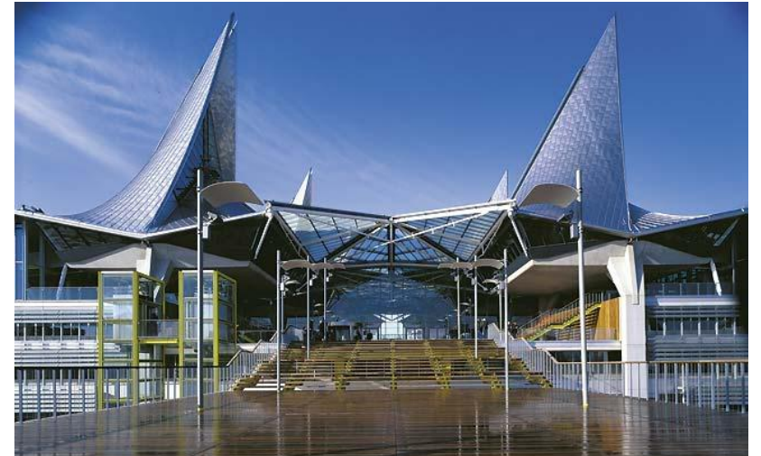
Gerechtsgebouw, Antwerpen Bekleding in AISI 316 Installatie: 2005
